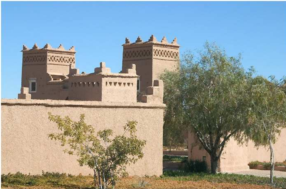
41- Construcción tradicional de tierra apisonada - Draa
