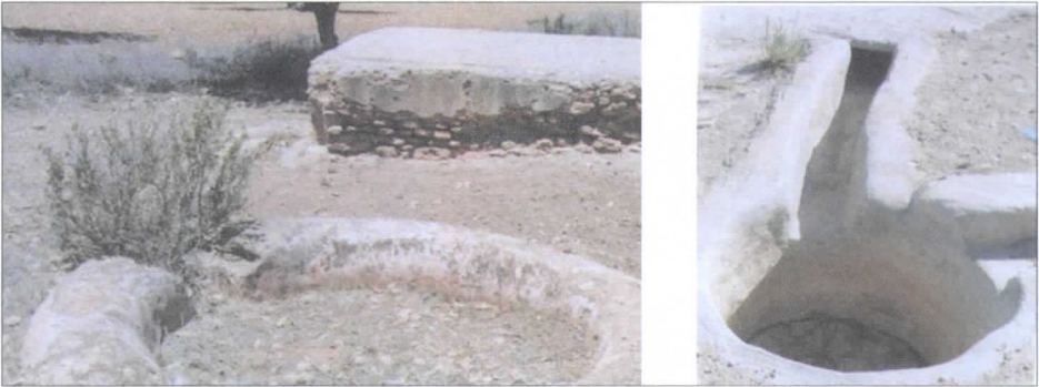
Tastayte : comparaison entre les anciennes (à gauche, plus grandes et en chaux) et les nouvelles (à droite, plus petites et en ciment)
