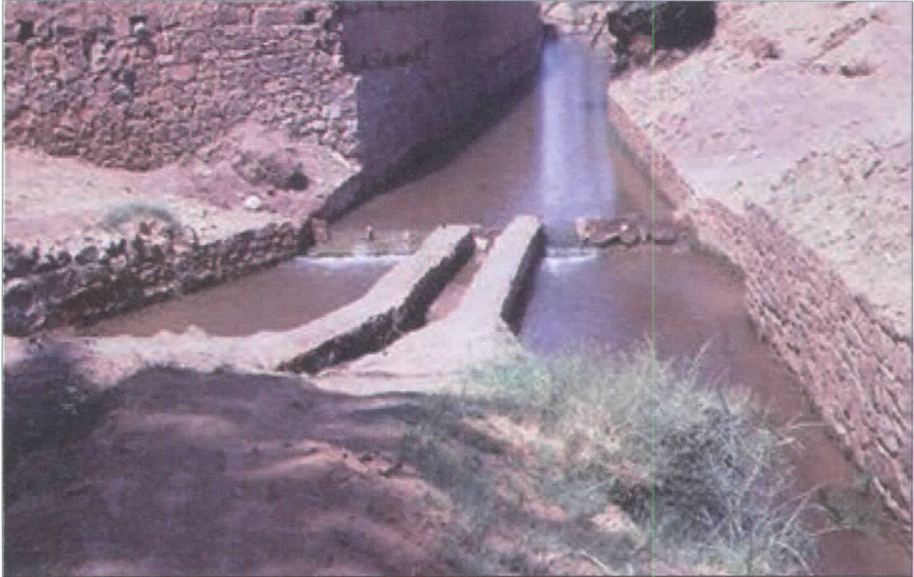
Photo 2. L'amazzal veille sur le bon fonctionnement d'une tafraout (bassin) et partage l'eau avec une tighirt
