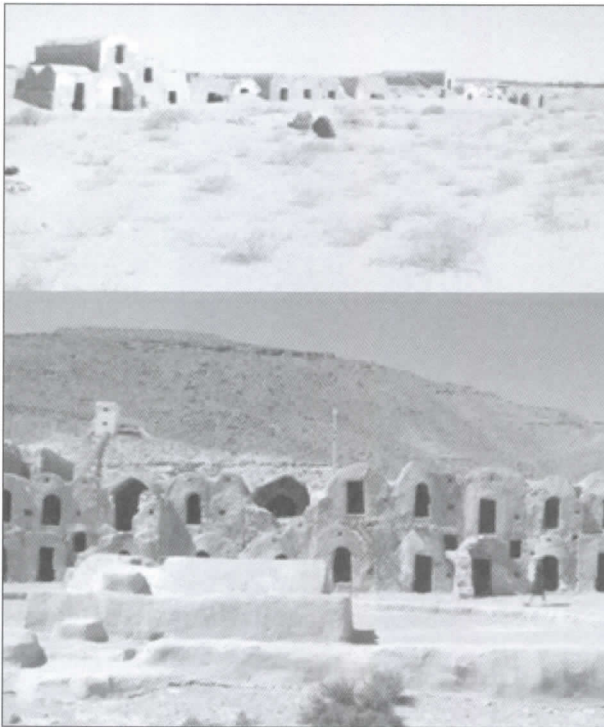
Fig. 13 : Ksour tunisien tombés en ruines ou sous-exploités (Source : photos de l'auteur)
