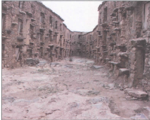
Photo 3 - L'intérieur d'un agadir (auteur).
