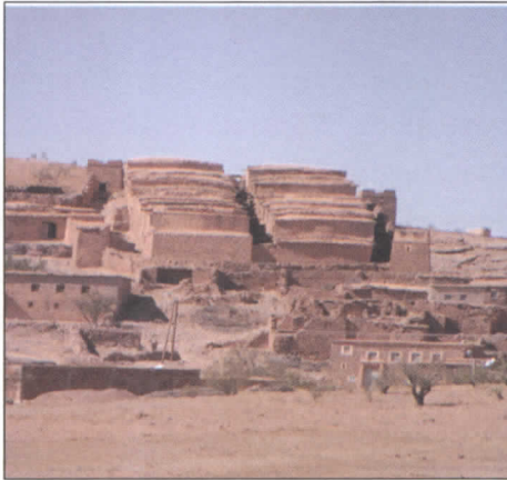
Photo 1 : Agadir Tizza des Iberkak. Type d'agadir rectiligne à allée centrale avec quatre tours. C'est un agadir en bon état architectural et fonctionnel. Cliché : El Fasskaoui 2009.
