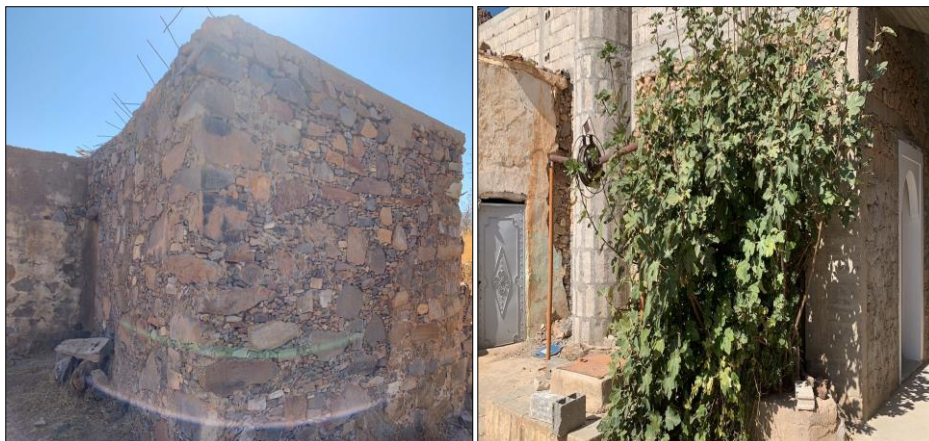
Photos 2-3 : Mur de l'ancien agadir et puits à l'intérieur de Tizi 1
