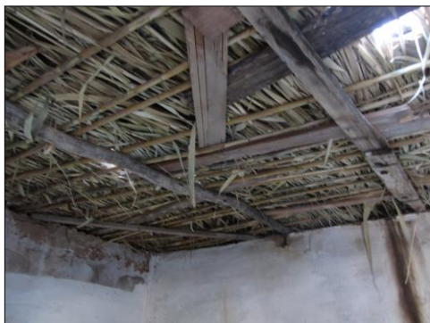
Photo 7 : Plafond du sanctuaire
