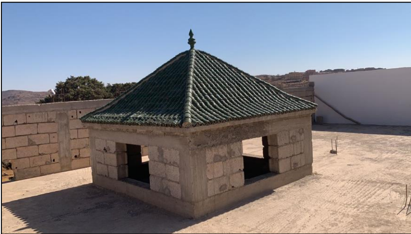
Les frontières de zawit n'Tizi n'Lawliya et sa qobba en construction
